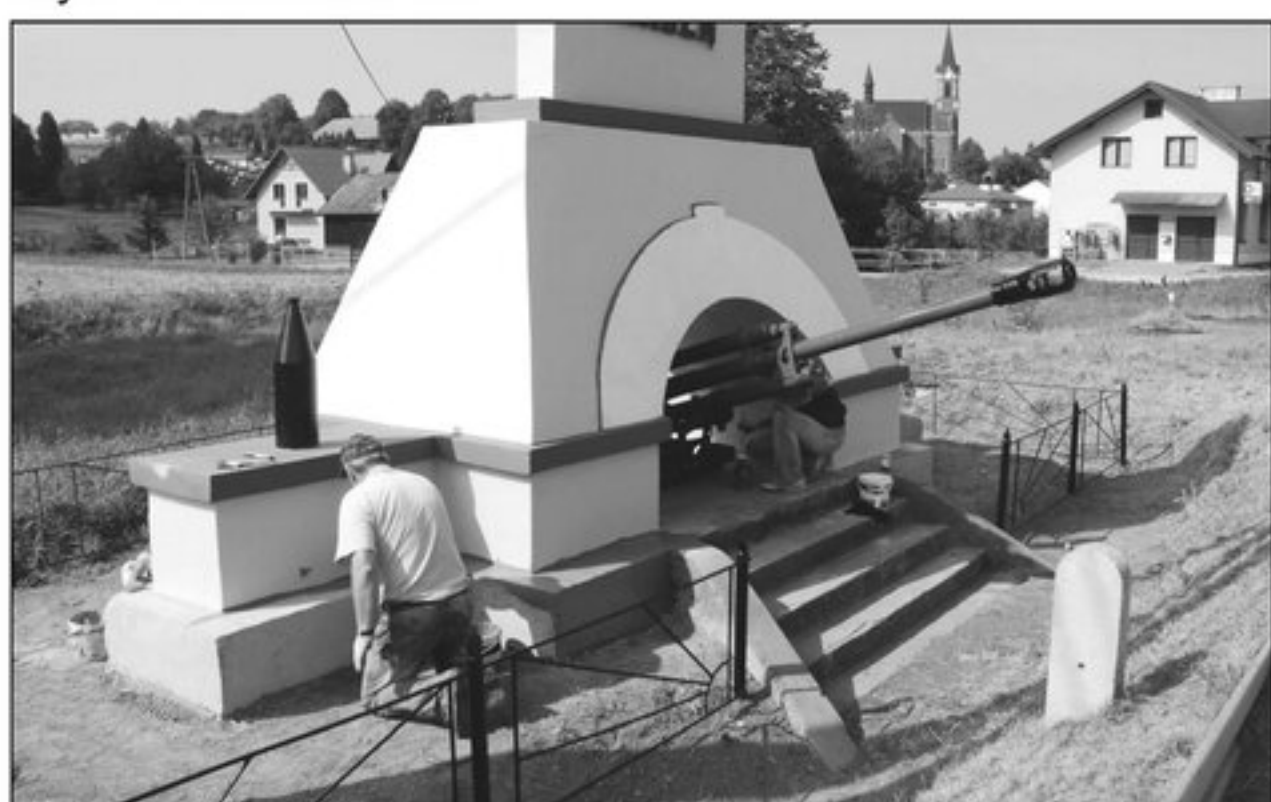
Prace renowacyjne poprawiają estetykę grabownickiego pomnika
